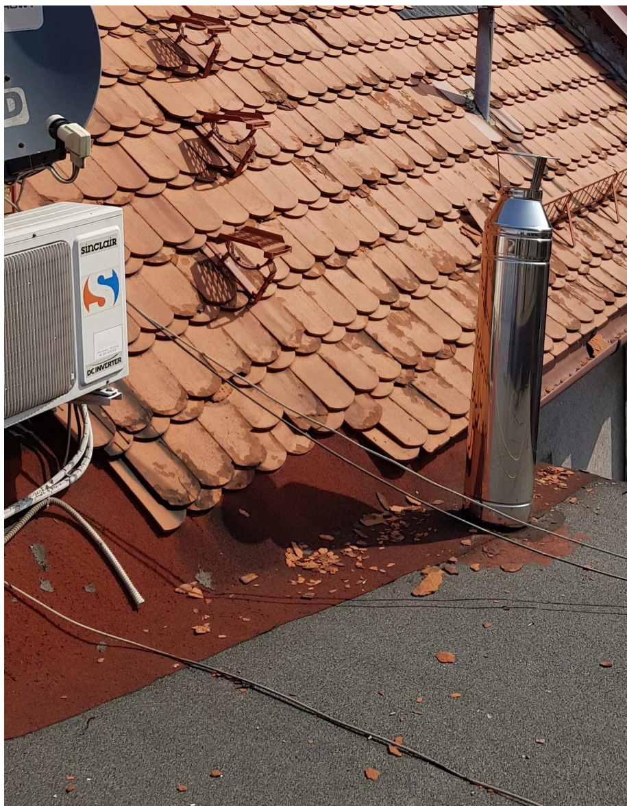
fot.3. Fragment południowej połaci dachu – stan istniejący. Widoczne uszkodzenia dachówek.
